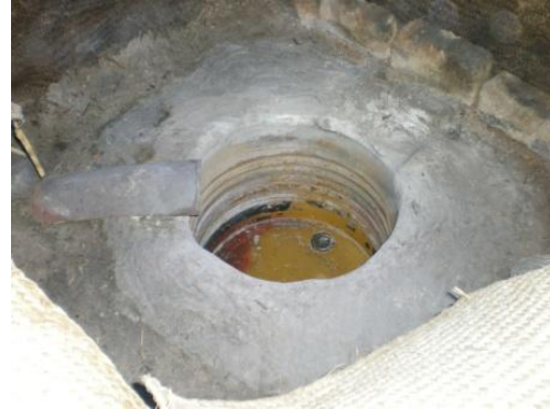
Figura 3.4: Depósito de agua dentro del horno
