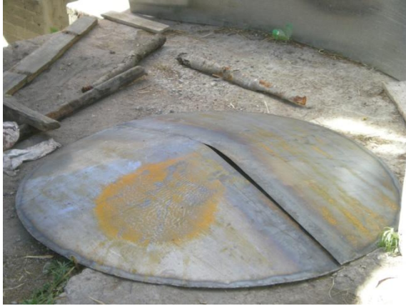
Figura 4.6: Abombado y armado de la tapa
