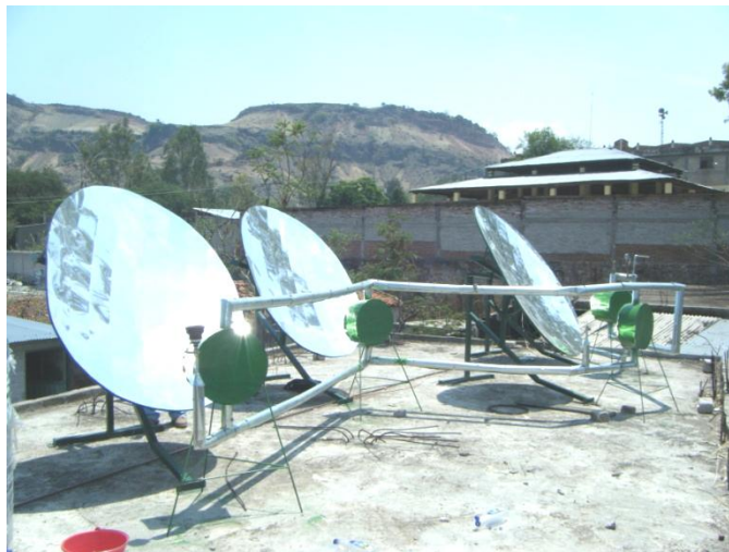
Figura 4.21 Instalación de los concentradores solares en la azotea de la empresa. Fuente: Fotografías del tesista
