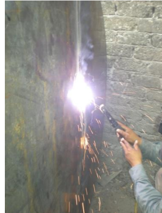
Figura 4.7: Soldadura de la tapa del horno
