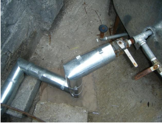
Figura 4.18: Conexión de red de vapor al horno
