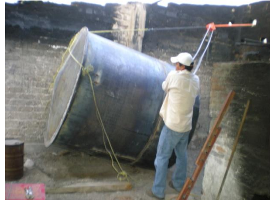
Figura 4.9: Maniobra con el polipasto para mover la carga Fuente: Fotografías del tesista
