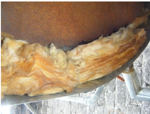
Figura 4.12: Instalación del aislamiento térmico Fuente: Fotografías del tesista
