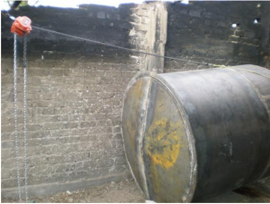
Figura 4.9: Maniobra con el polipasto para mover la carga Fuente: Fotografías del tesista
