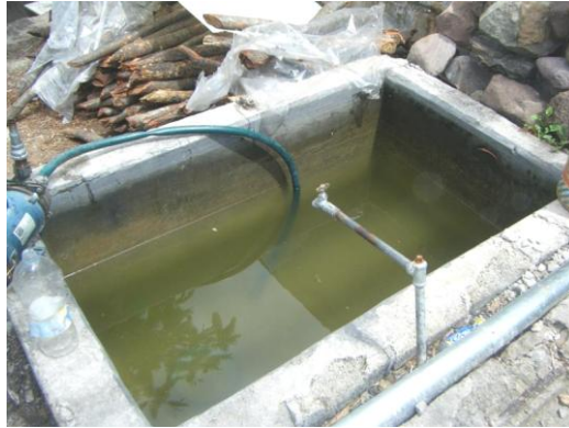
Figura 3.11: Estanque de suministro de agua para el proceso Fuente: Fotografías del tesista
