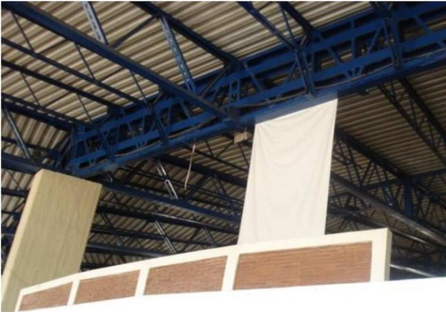
La cubierta está conformada por el denominado multytecho y es soportado por vigas y trabes metálicas.
