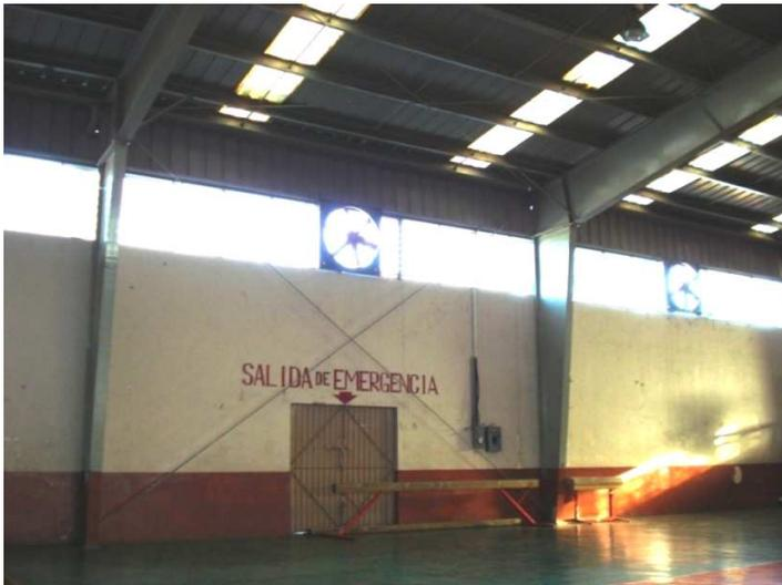
Los muros alcanzan una altura de ocho metros. En la parte superior, se localizan las ventanas, que debido a su tamaño proporcionan poca iluminación y ventilación.
