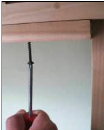
Fotografía 7-13 Aseguramiento de piezas laterales sobre riel de cabecera.
