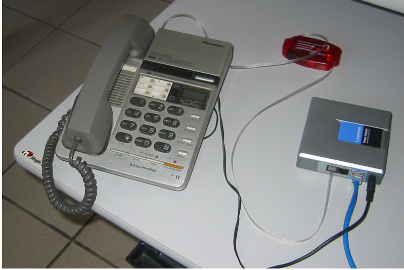
Figura 4.6. Teléfono IP registrado en el Servidor/IP PBX.
